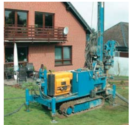
Bohrung für Erdwärmesonde
